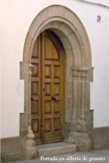
Portada en sillería de granito
